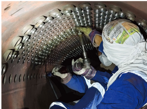
LNG main boiler retubing
